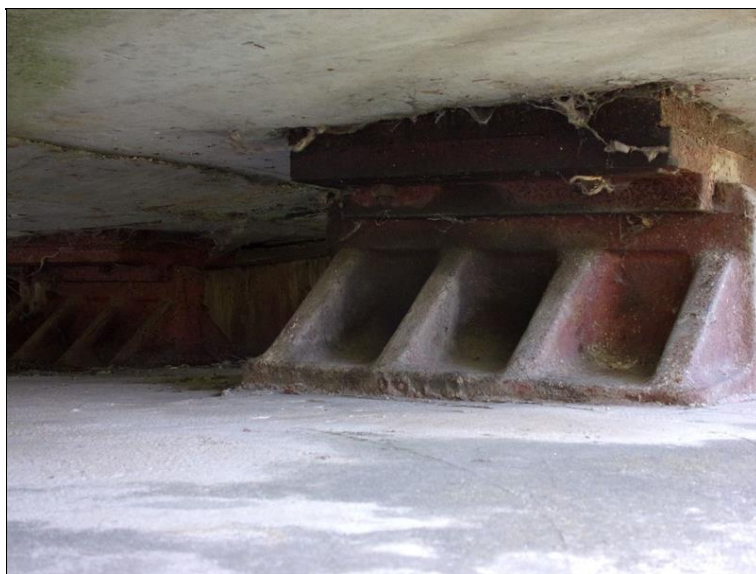
Pevná ocelová ložiska na OP1
