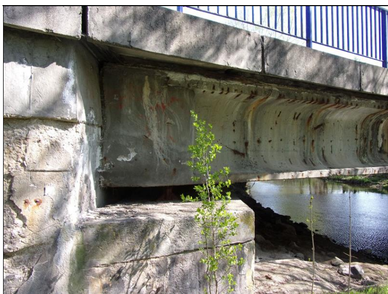
Detail ukončení a uložení NK na OP1
