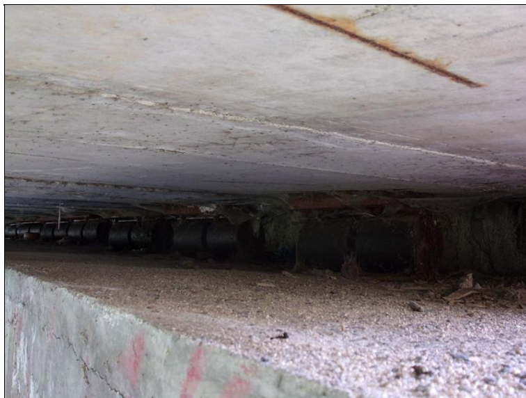
Ocelová válcová ložiska na OP2
