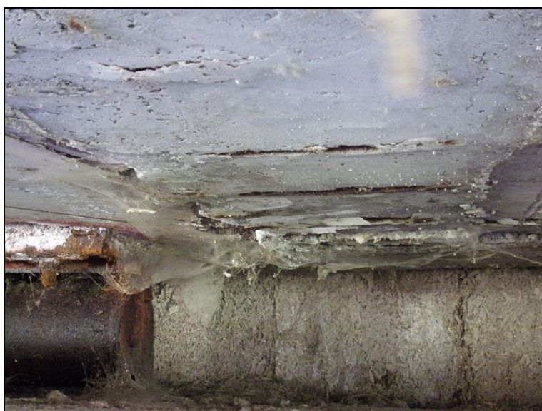
Dobetonávka mezi nosíky v místě uložení
