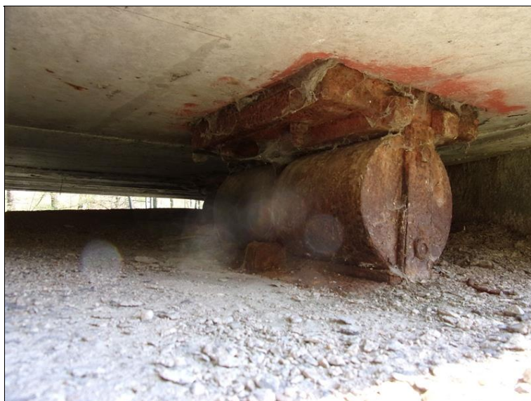
Povrchová koroze krajního válcového ložiska
