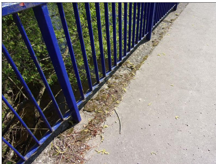
Vegetace na chodníku v místě zábradlí
