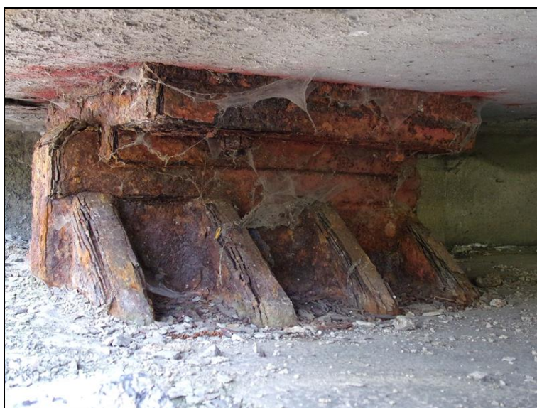
Koroze pevného ložiska na OP1
