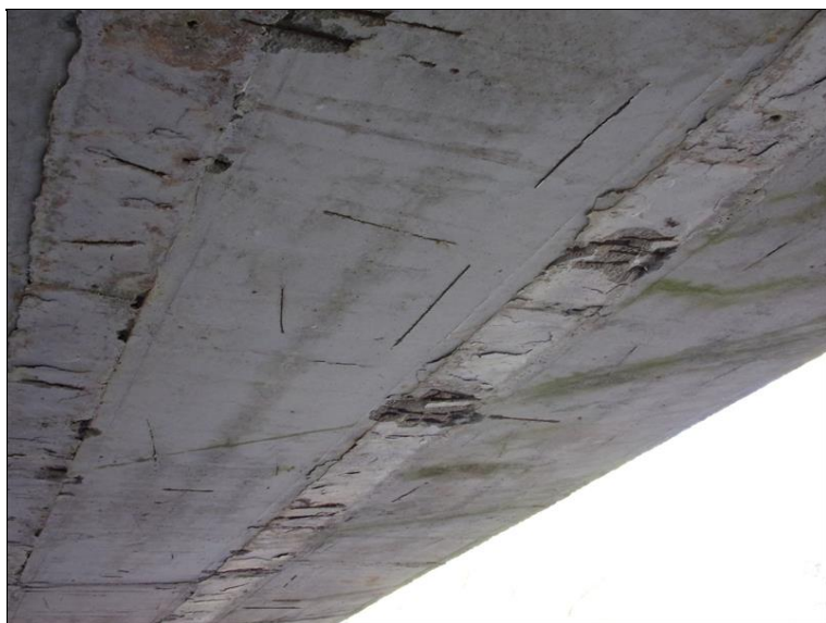
Podhled NK - stav dobetonávek mezi nosíky
