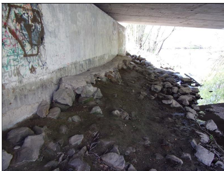
poškozené odláždění kynety u OP2
